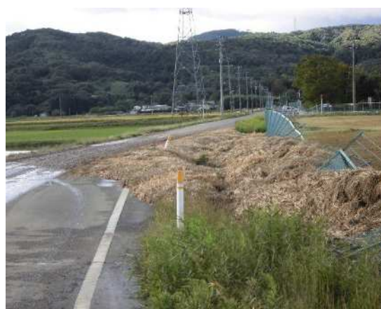
稲わら流出により倒壊したフェンス
